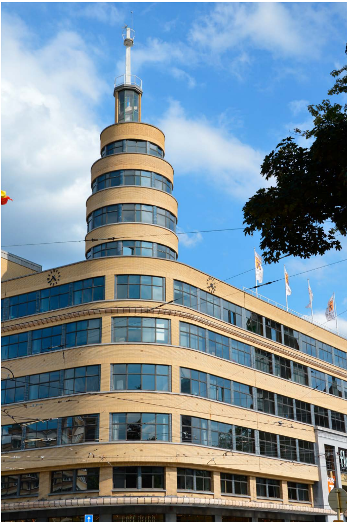
ex. Bâtiment Flagey à Bruxelles, Belgique © Busoni
