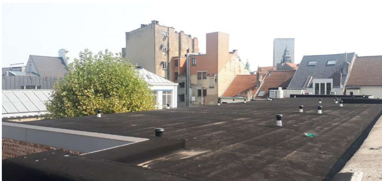
Toiture en intérieur d'îlot - Ecole Buls-Lemonnier, place Roupe 28-30 - Septembre 2020 © ERU & AAC
