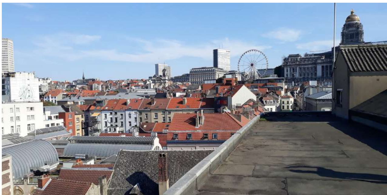
Toiture en intérieur d'ilot - Ecole Diderot, rue des Capucins, 58 - Octobre 2020 © ERU & AAC
