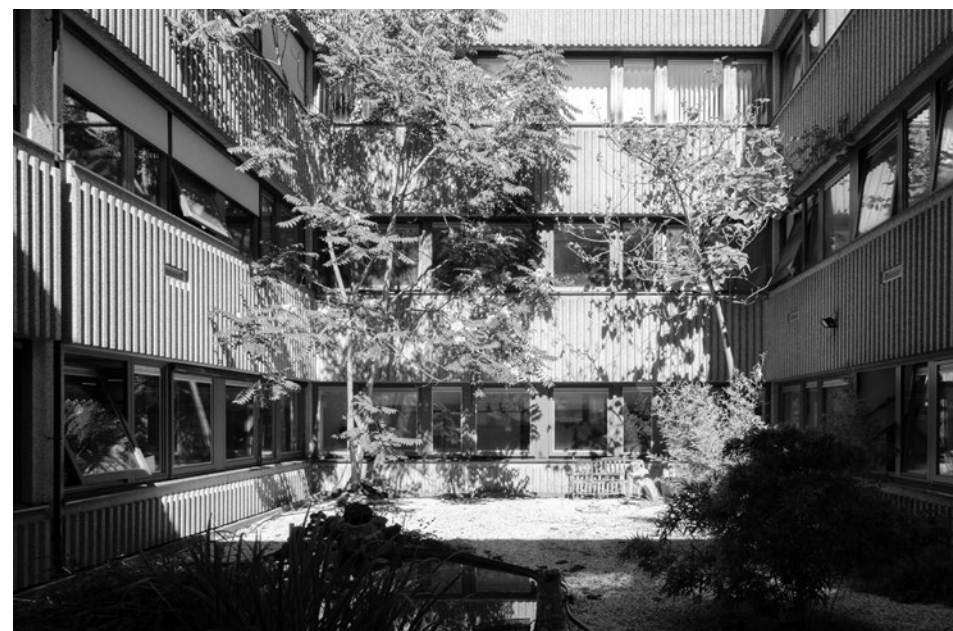
Vue depuis le patio de la caserne des pompiers rue de l'Héliport © Julien Bietagne
